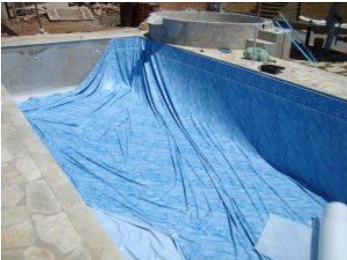
A piscina de **vinil** é construída sobre outras estruturas, como a alvenaria, sendo que o vinil é o próprio material de acabamento estético e funcional.
